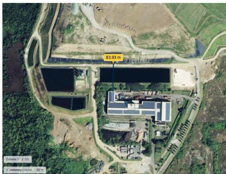
Distance minimale entre les installations Ecodec et le casier en cours d'exploitation depuis 2013 (source geoportail.gouv.fr)
