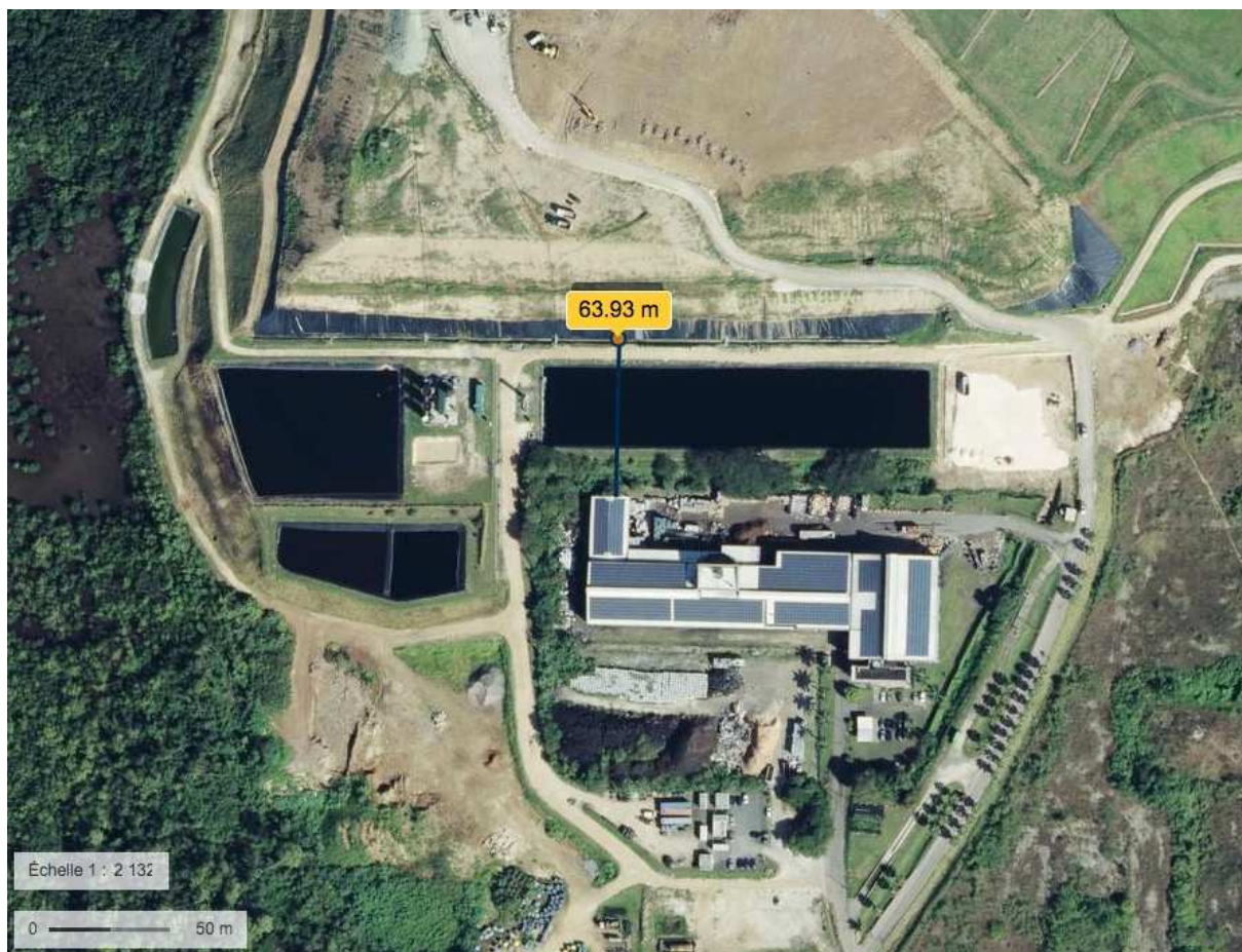
Distance minimale entre les installations Ecodec et le casier en cours d'exploitation depuis 2013 (source geoportail.gouv.fr)
